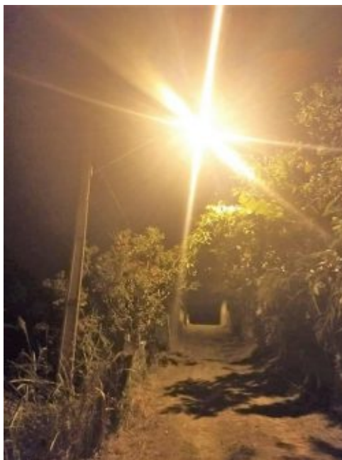
Luminária instalada na rua do Carmo/Foto: Gabinete Parlamentar
