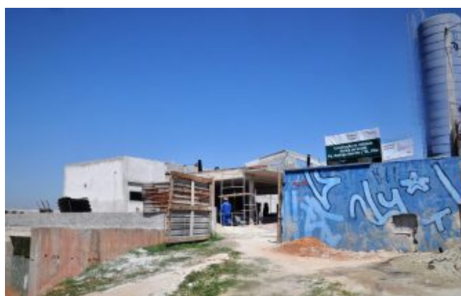
Vista da UBS Vila Pilar
