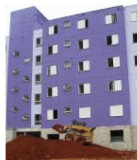
Obra da CDHU no Jardim Emília. Junho/16
