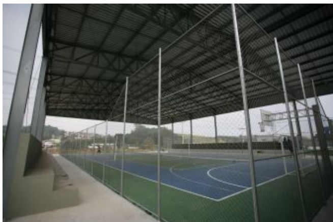
Quadra coberta do novo equipamento esportivo
