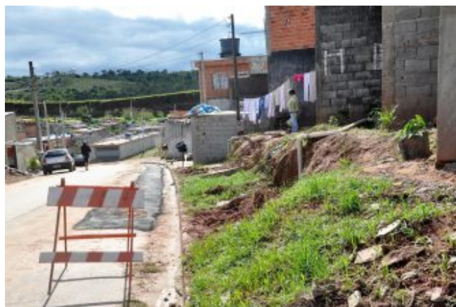
Serviços executados na rua José Lino de Souza (antiga rua 59)
