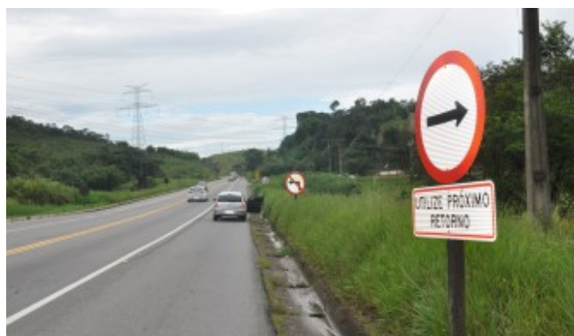
Trecho da Mogi-Dutra em Arujá
