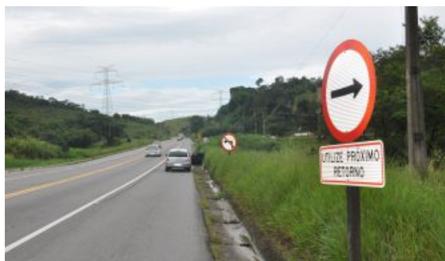
Trecho da Mogi Dutra em Arujá
