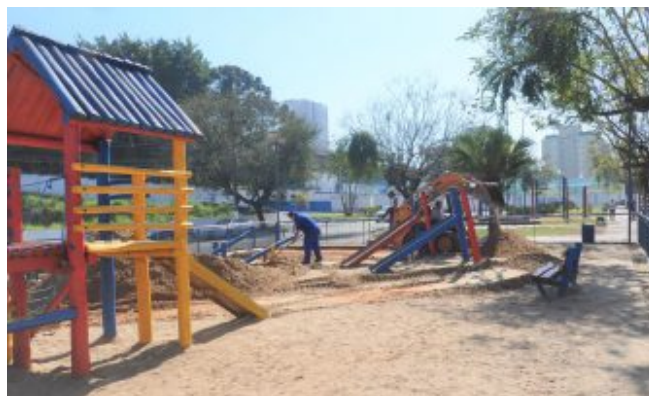
Serviços de revitalização do parque na Avenida Amazonas
