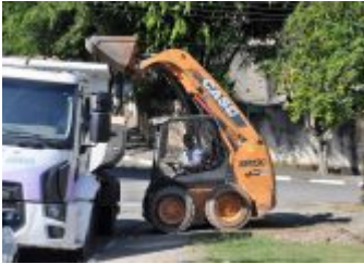
Retirada de terra, areia e nivelamento
