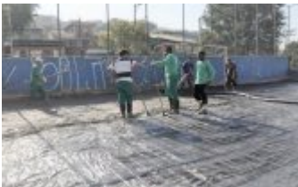
Instalação de lonas e telas (30/8)
