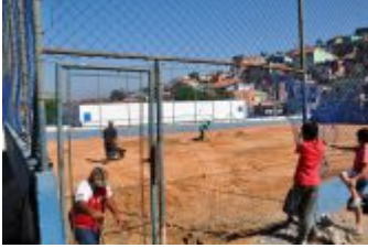
Início dos trabalhos no dia 29/8
