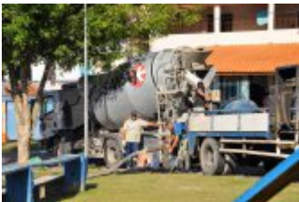
Trabalho de concretagem
